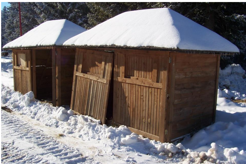
Илустрација 47. Контејнери 1.1 м 3 у посебној заштитној конструкцији
