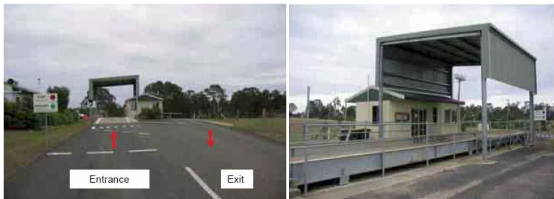
Илустрација 52. Улаз и вага на улазу у трансфер станицу са или без надстрешнице
